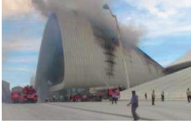
Figure 26. 20 Temmuz 2012 H. Aliyev Center Fire incident.
